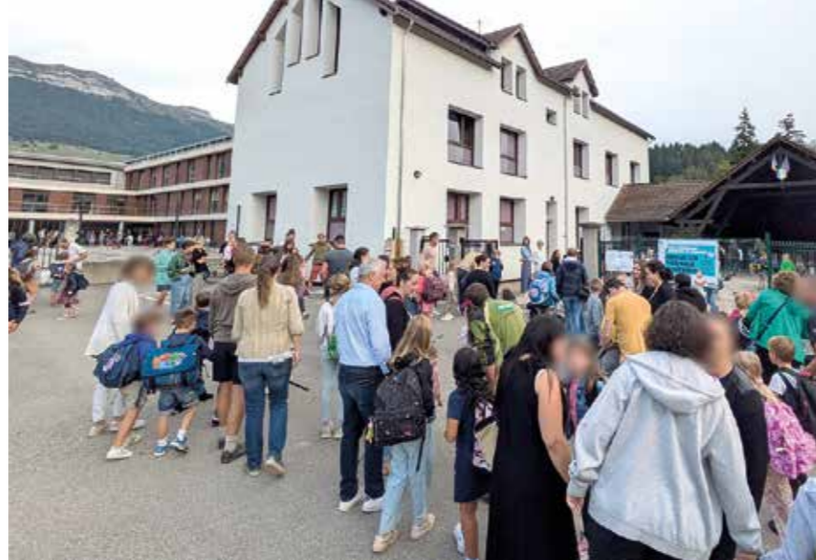
Rentrée des classes à l'élémentaire de Monestier de Clermont, école dont les travaux de rénovation thermique ont été achevés cet été. L'installation d'un terrain de sport est prévu dans la cour pendant les vacances d'automne (coût : 45 000 euros)
